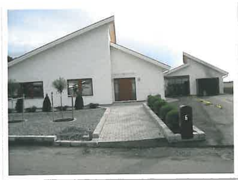
Figur 2. Garaget det brunnit i syns till höger i bild.
